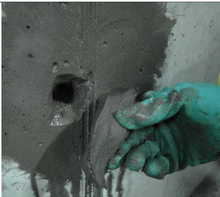
Рисунок 7.2.55 - Заполнение отверстия
