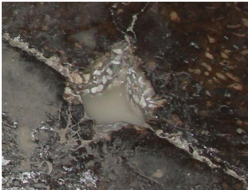
Рисунок 7.2.33 - Безнапорная течь
