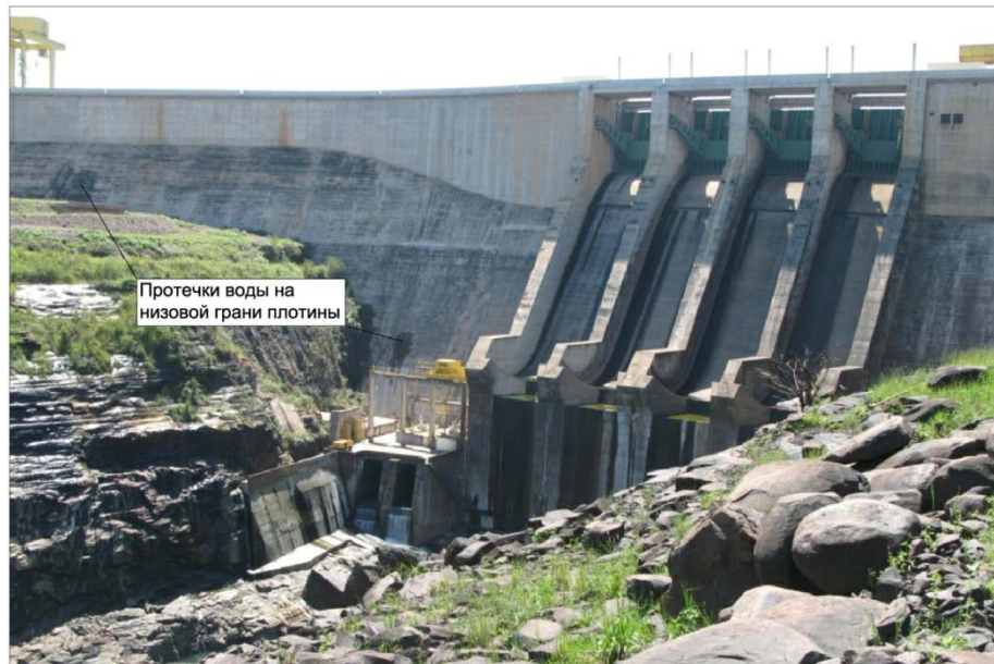
Рисунок 6.2.1 - Плотина из укатанного бетона
