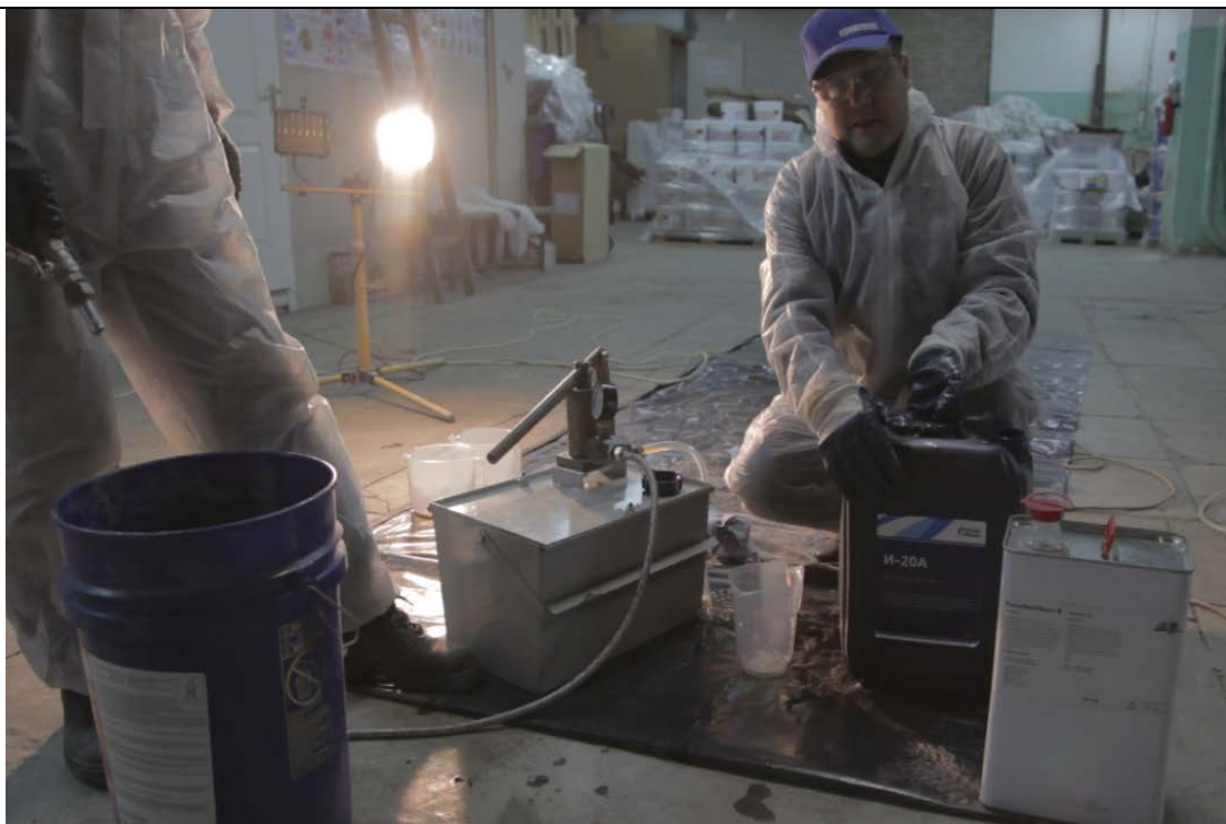
Рисунок 7.2.28 - Промывка гидравлическим маслом
