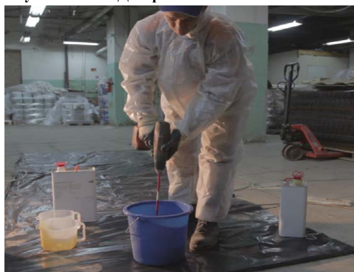
Рисунок 7.2.31 – Приготовление необходимого объема смеси компонентов смолы
