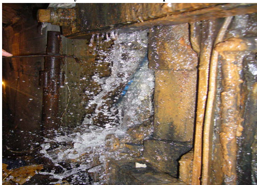
Рисунок 7.2.34 - Напорная течь
