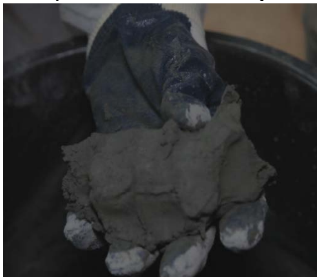
Рисунок 7.2.25 – Приготовление растворной смеси «Скрепа М500 Ремонтная»
