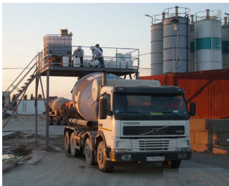
Рисунок 7.1.2 - Пример введения добавки «Пенетрон Адмикс» в автомиксер
