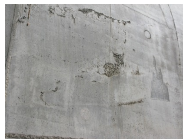
Рисунок 6.8 - Напорные водоводы гидроаккумулирующей станции: а – панорама строительства водоводов; б – дефектные участки бетона на поверхности водовода
