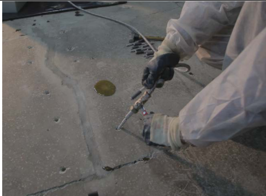
Рисунок 7.2.31 - Выполнение инъекционных работ
