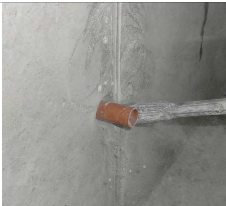
Рисунок 7.2.53 - Удаление пластиковой втулки
