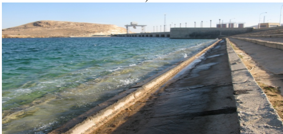
Рисунок 6.6 - Железобетонные крепления откосов грунтовых плотин:
