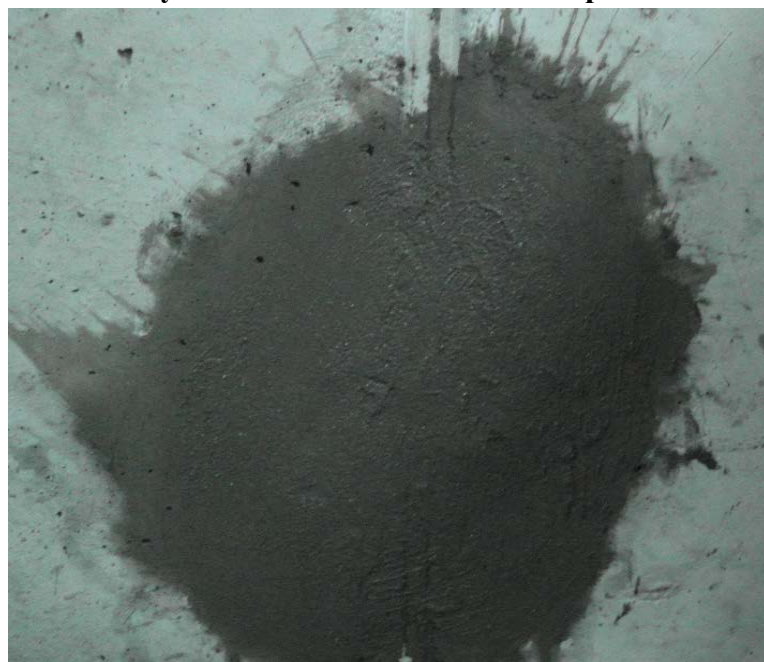
Рисунок 7.2.56 - Общий вид отверстия после выполнения гидроизоляционных работ
