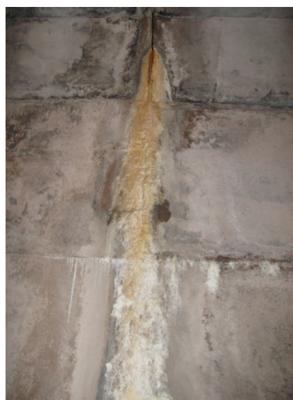
Рисунок 6.7.2 – Транспортно-кабельный туннель: а – выходной оголовок туннеля; б – фильтрация воды через стены туннеля с выносом свободной извести и продуктов коррозии арматуры
