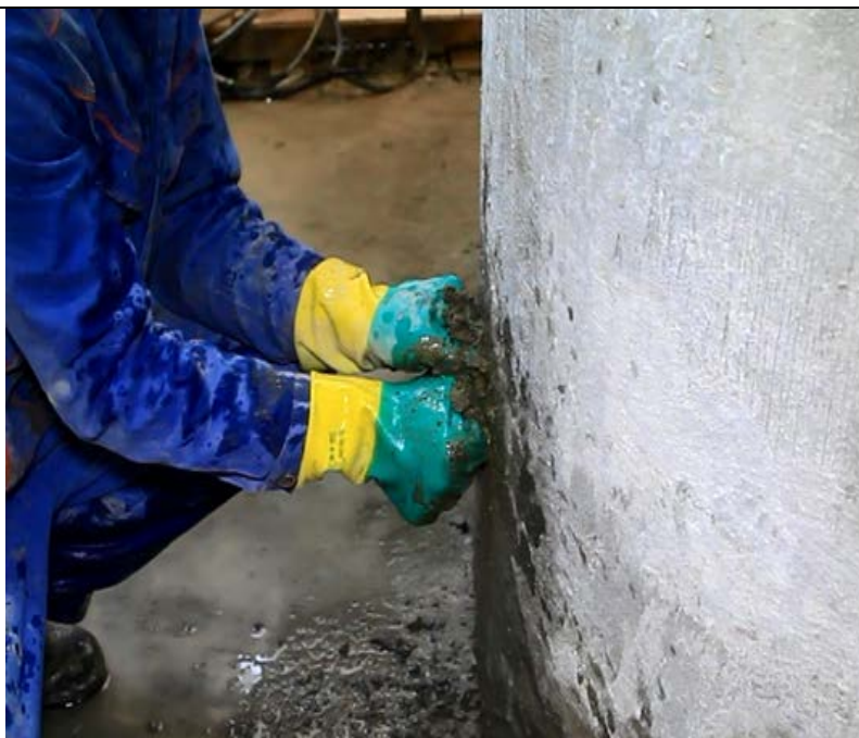
Рисунок 7.2.38 – Удерживать растворную смесь в полости течи
