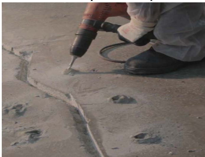
Рисунок 7.2.22 – Бурение отверстий для установки инъекторов
