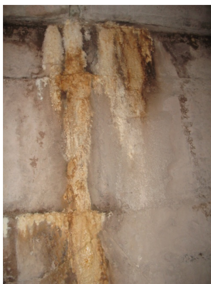
Рисунок 6.7.2 – Транспортно-кабельный туннель: а – выходной оголовок туннеля; б – фильтрация воды через стены туннеля с выносом свободной извести и продуктов коррозии арматуры
